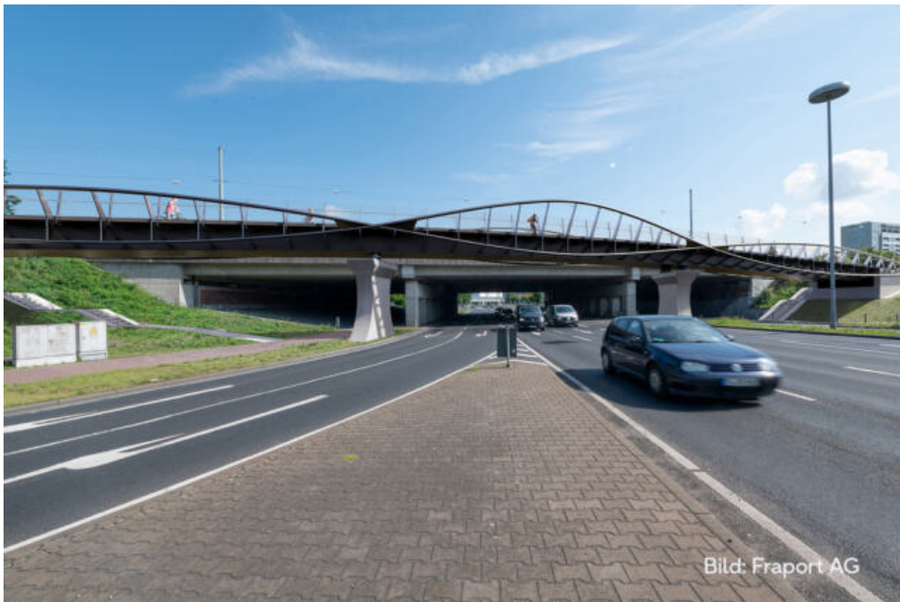
Rad- und Gehwegbrücke am Flughafen Frankfurt
